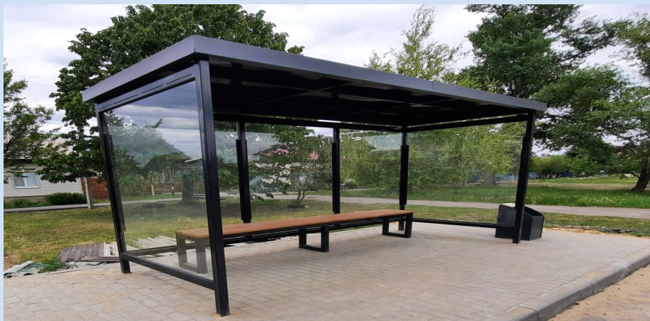
Устройство остановочных павильонов в г.Бутурлиновка
