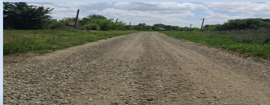
Текущий ремонт дороги по ул. Подлесная в с.Клеповка
