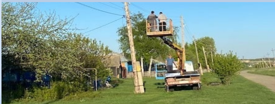
Текущий ремонт сетей уличного освещения в с.Васильевка
